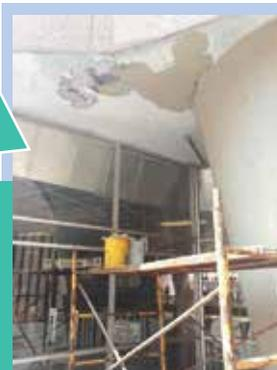
Problemática: Deterioro de concreto en techos y exposición de acero de refuerzo en estación de metro del sistema Metrorey, Monterrey, N.L.
