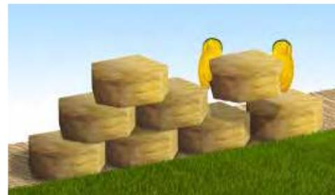
Coloque la segunda hilera al principio de una pieza de Garden Wall que previamente ha partido a la mitad con la ayuda de un martillo y un cincel. La pestaña conectora de la pieza deberá exceder ligeramente la unidad debajo de ella. Continúe de la misma manera para completar más hileras. Una capa de grava detrás de la pared ayudará con el drenaje.
