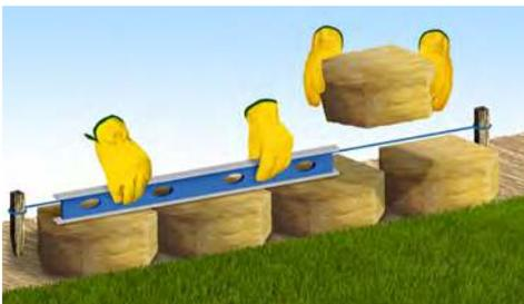
Coloque la hilera base. Utilice un hilo para ir cuidando el alineamiento, poniendo por detrás las piezas. Coloque las piezas una enseguida de otra en la base, con ayuda de un nivel cheque que en ambas direcciones queden parejas.
