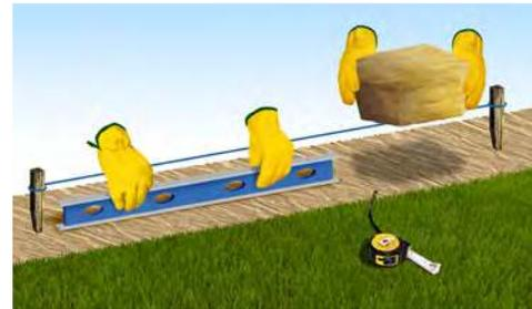
Excave una zanja de 30 cm de ancho y de 5 a 10 cm de profundidad. Asegúrese de compactar el fondo. Utilice arena como plantilla para dar nivel y recibir la primera hilera de Garden Wall.
